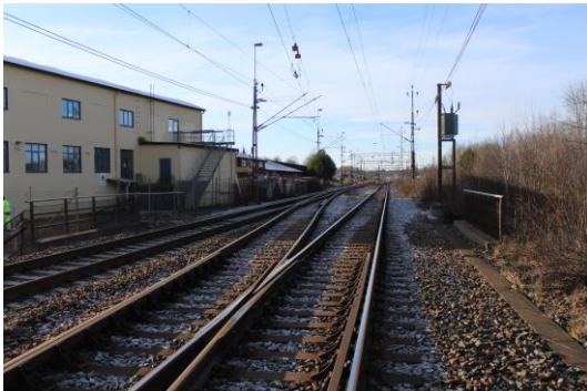
Bild 1. Vy över spårområde vid km 377+000.
