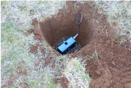
Bild 4. Exempelbild från montering, mätpunkt 2 före jordtäckning.
