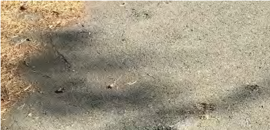
Figur 16. Exempel på sprickbildning i asfalt pga rötter. Upplevs som svåråklat pga kraftiga vibrationer.
