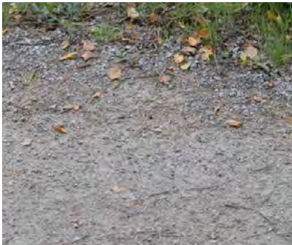
Figur 15. Stensmjöl med kalk, växligheten har svårt att etablera sig i den hårda beläggningen.
