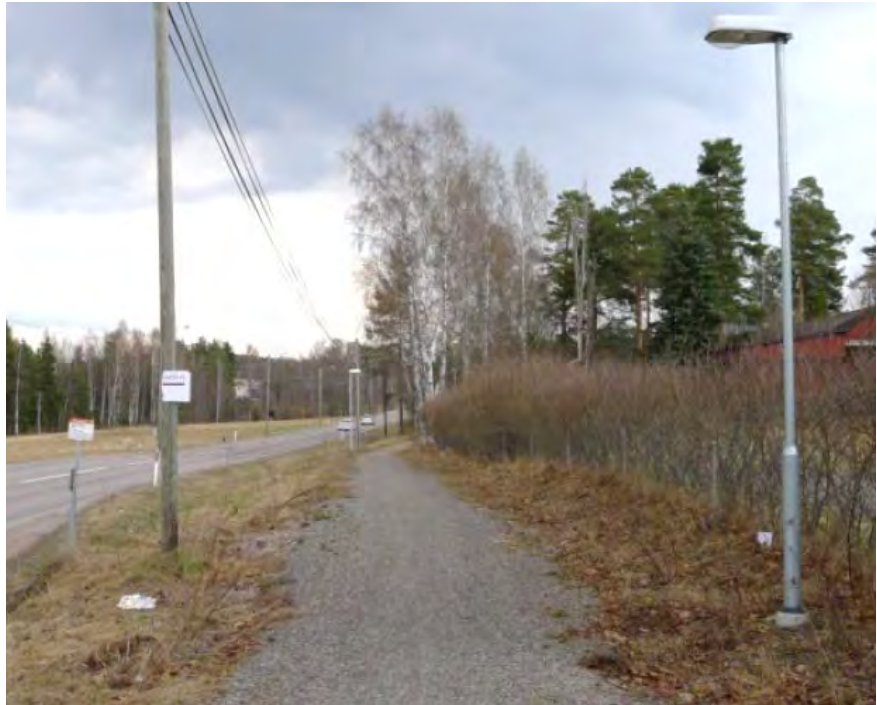
Figur 9. Exempel på sommarcykelväg med "grövre" grus (förmodligen 0-16 mm) som upplevs svårt att cykla på.
