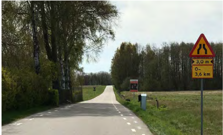
Figur 17. Exempel på utmärkning av bygdeväg, notera informationsskylt i bakgrunden. Den gamla ursprungliga vägmarkeringen är synlig i början på objektet.
