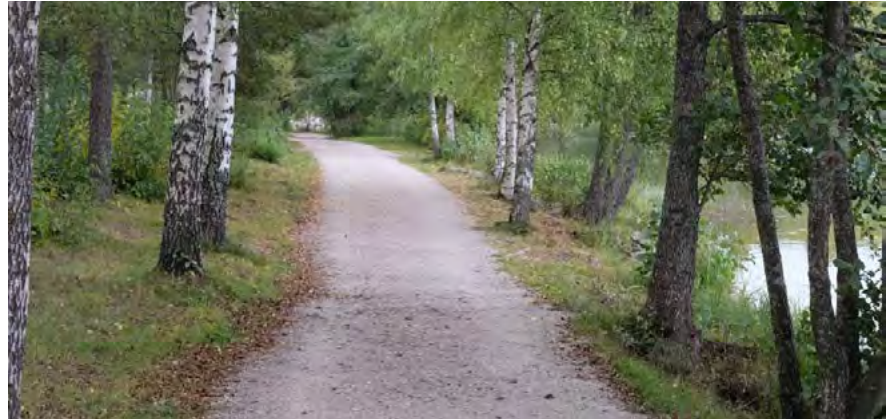
Figur 14. Exempel på stråk med kalkgrus på befintlig underbyggnad.
