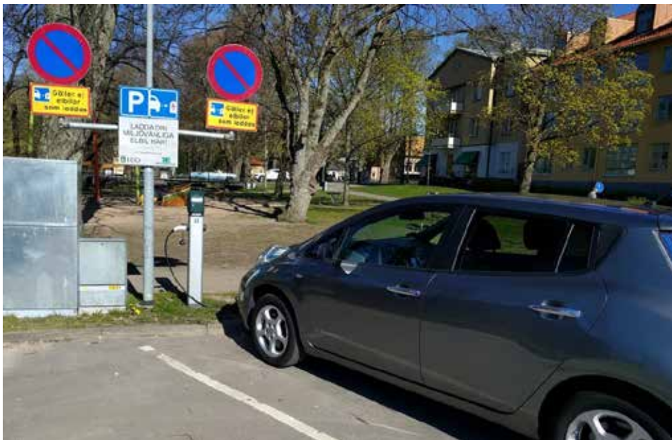
Bild 13 Laddplats i Hjo med tydlig skyltning om parkeringsförbud. Bild från www.uppladdning.nu
