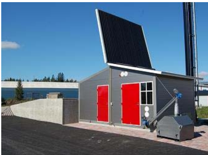
Figur 4.1. Exempel mobil panncentral, finsktillverkad MegaCont, 400 kW.
